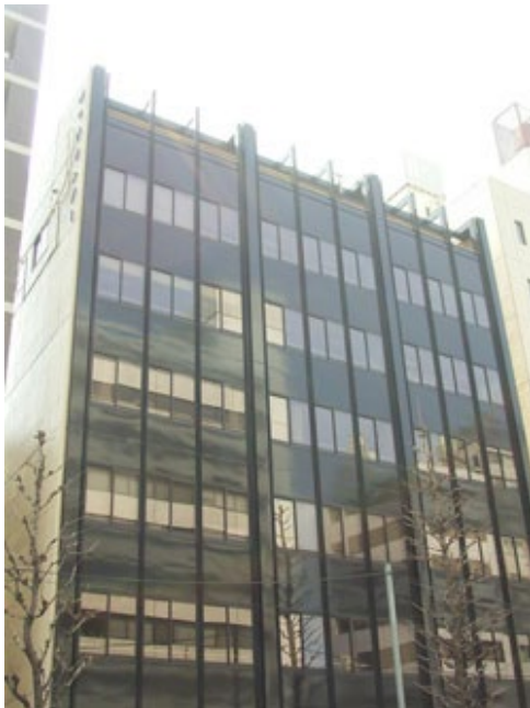
めっきセンタービル(写真1)
